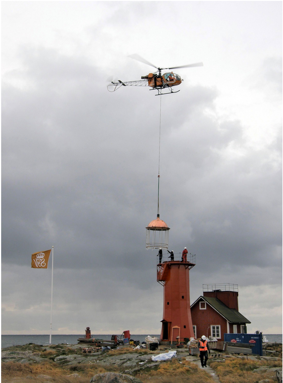
Lanterninen flygs ut för att återplaceras på Tylöns totalrenoverade fyr. Till höger syns mistsignalhuset. Tidigare publicerad i Svenska Fyrsällskapets tidskrift Blänket 2011:2. Foto: Anders Röö, SFV, 2008.
